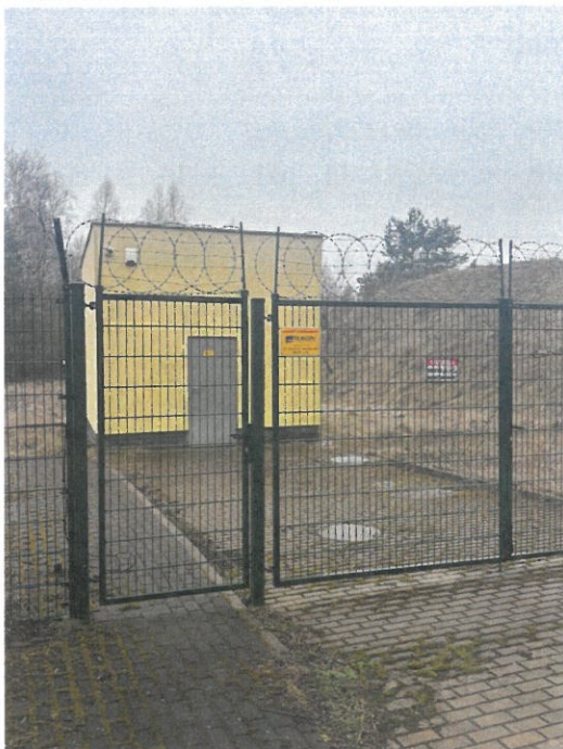
Zdjęcie nr 1. Hala pomp
