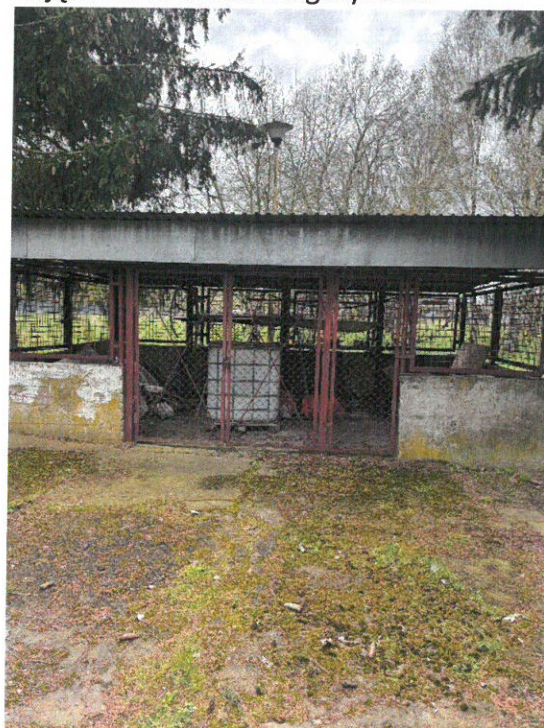
Zdjęcie nr 9. Wiata magazynowa
