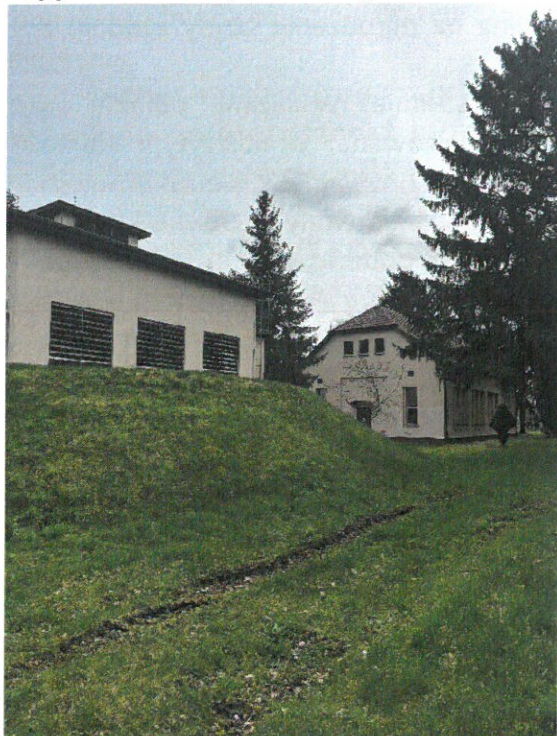
Zdjęcie nr 2. Budynek aeracja i hala filtrów
