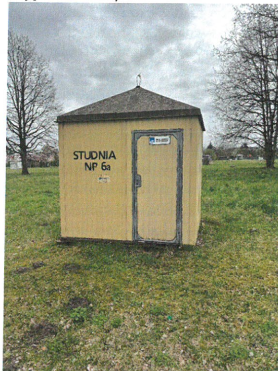
Zdjęcie nr 7. Przykładowa studnia z zewnątrz
