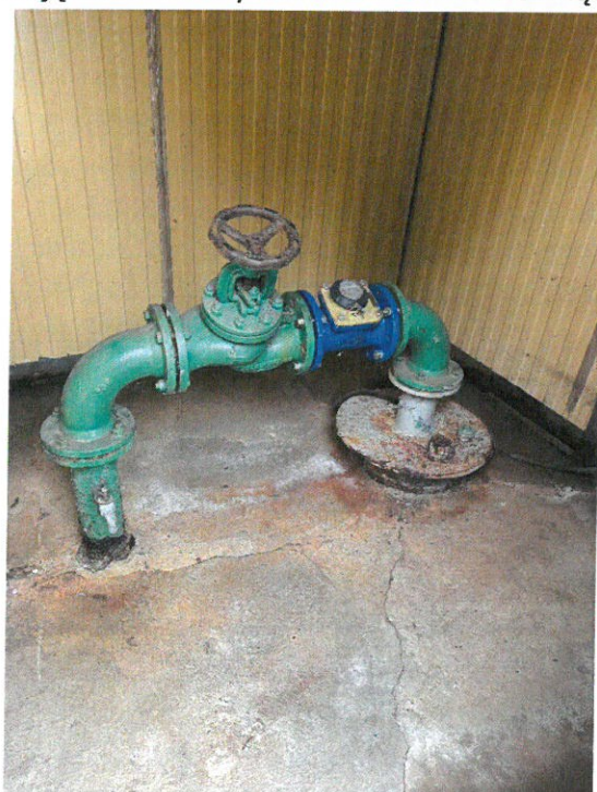
Zdjęcie nr 8. Przykładowa studnia wewnątrz
